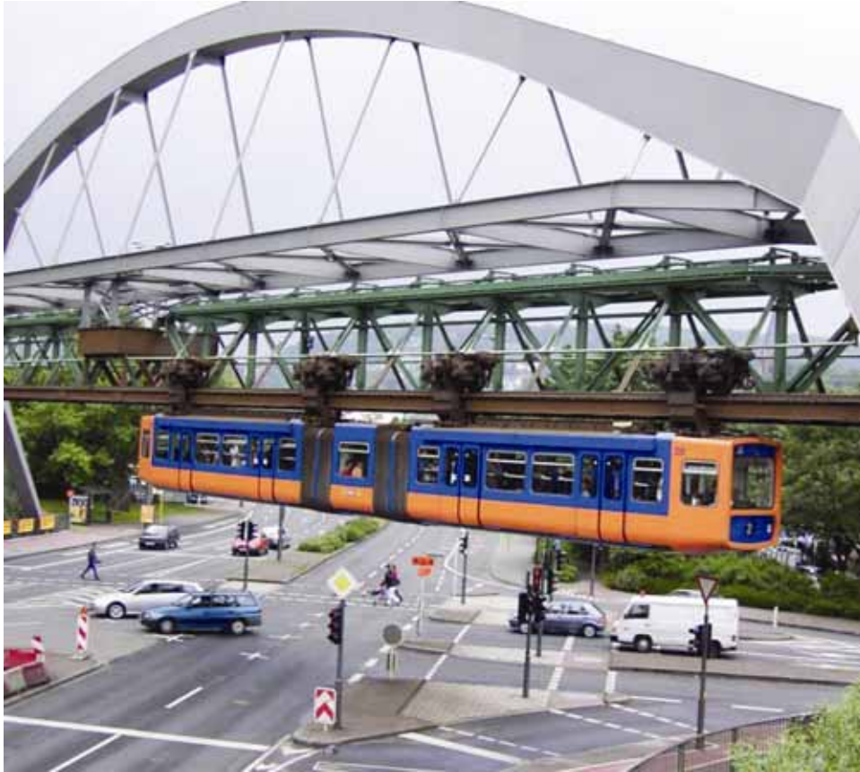
Figur 2.3. Schwebebahn i Wuppertal, Tyskland, vid 2000-talets början. Källa: Wikimedia
