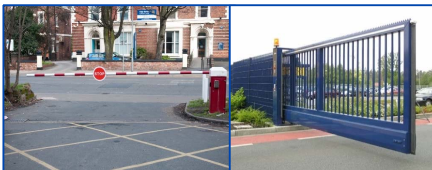
Figur 6 Bild t.v. Automatiskt styrd bom. Bild t.h. fjärrmanövrerad teleskopisk grind för hög säkerhet (foto: Nationwide Fencing Service Ltd)
