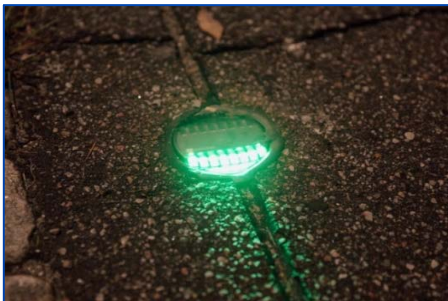
Figur 10 Exempel på installerat ledljus i körbana (foto: Köpenhamns kommun)
