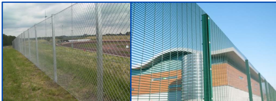
Figur 5 Bild t.v. Stängsel av lägre säkerhetsklass mot främst personligt intrång (foto: Helsingborgs Stängsel AB). Bild t.h. Stängsel med hög säkerhetsklass med möjlighet att stå emot maskinell åverkan (foto: Nationwide Fencing Service Ltd.)
