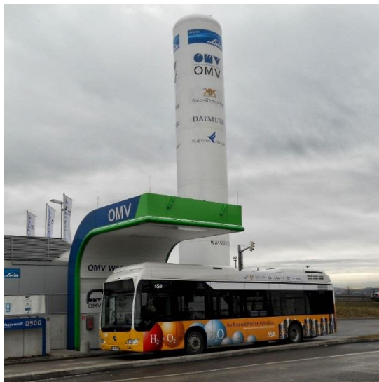
Figur 22 Tankstation för vätgasbuss vid flygplatsen i Stuttgarts 48
